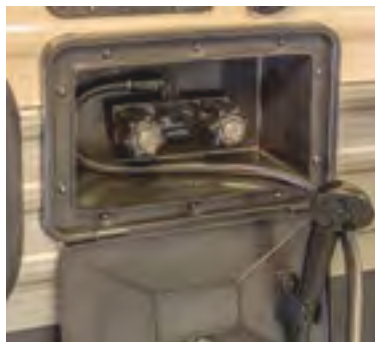
Douche extérieure avec eau chaude et froide
