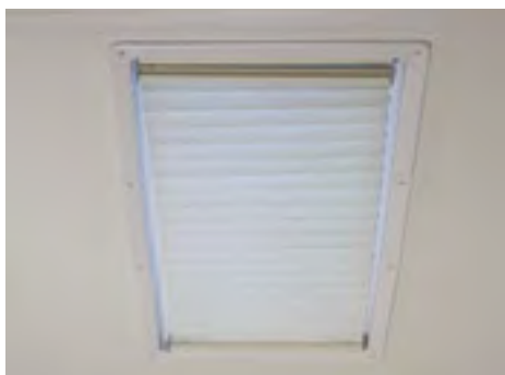
Puits de lumière avec store dans la cuisine (n/d CS & Caravanes Destination)
