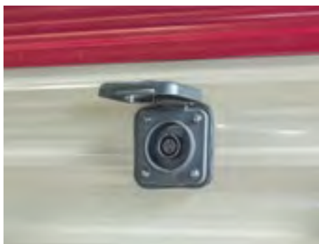
Préparé et filé pour panneau solaire
