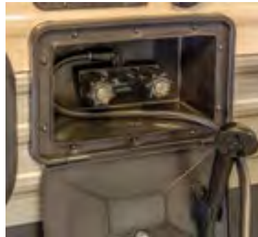
Douche extérieure avec eau chaude et froide
